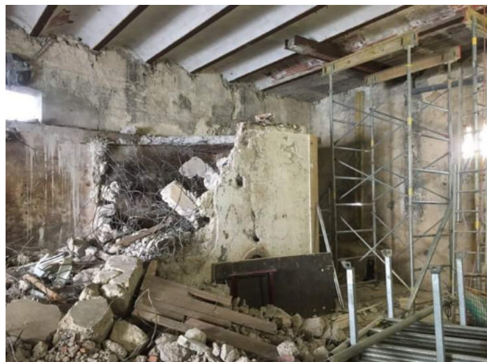
Chantier de la requalification de la Maison Malavialle
